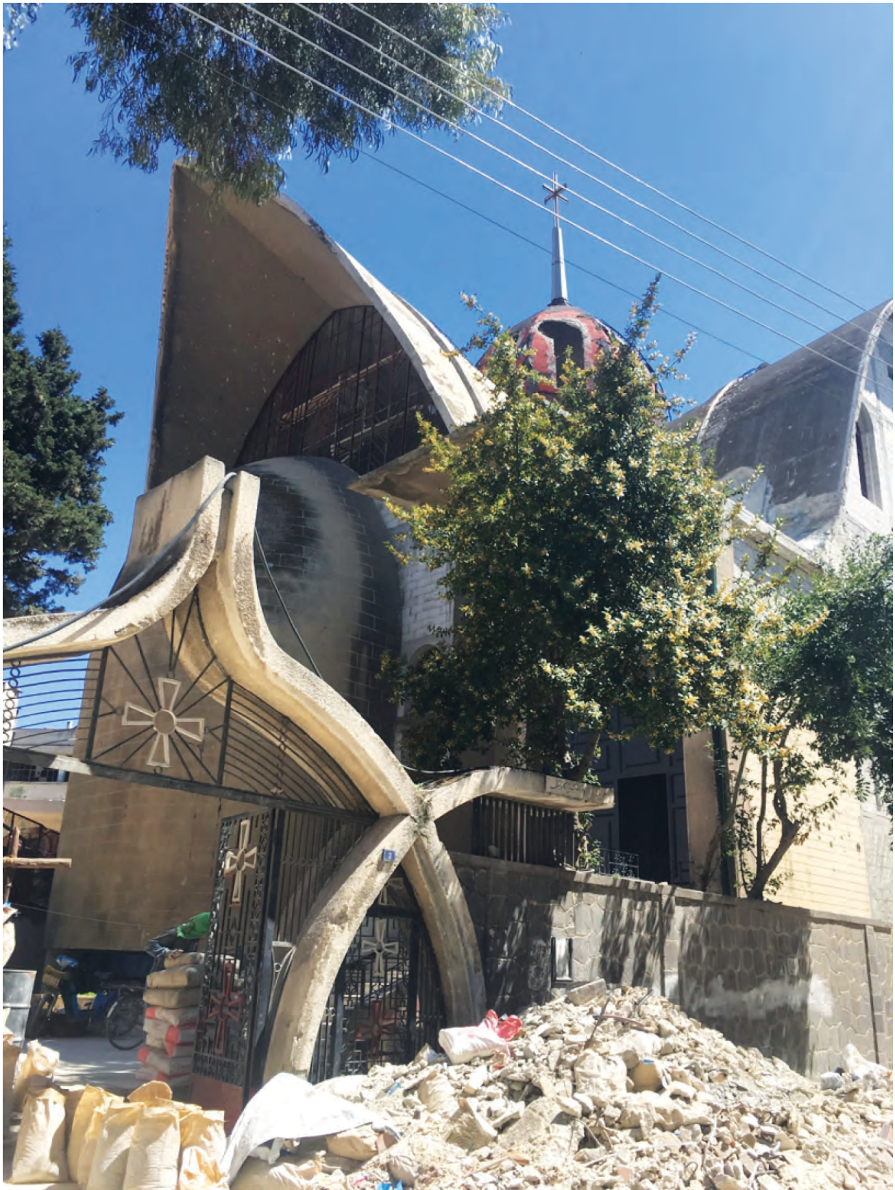
Cathédrale de Homs en cours de restauration
